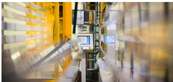
Cabine de poudrage (Cetal).
